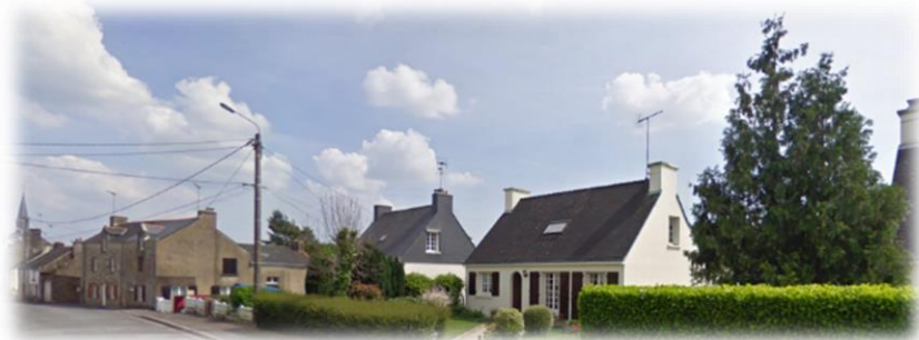
Rupture nette entre les styles d'urbanisation, a la sortie du cœur de bourg
