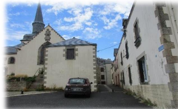
Urbanisation dense de la place Saint-Pierre
