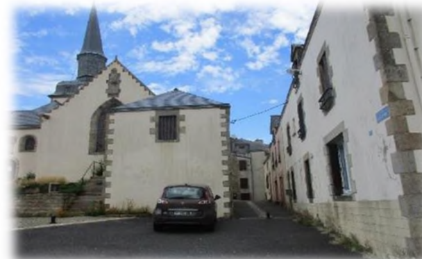
Urbanisation dense de la place Saint-Pierre
