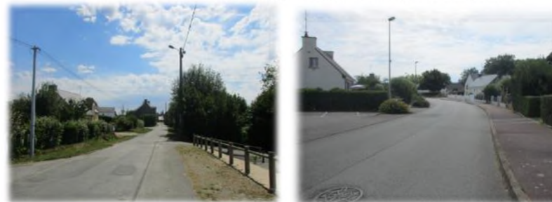
Voies dans le centre-bourg, intégrant ou non les déplacements piétons
